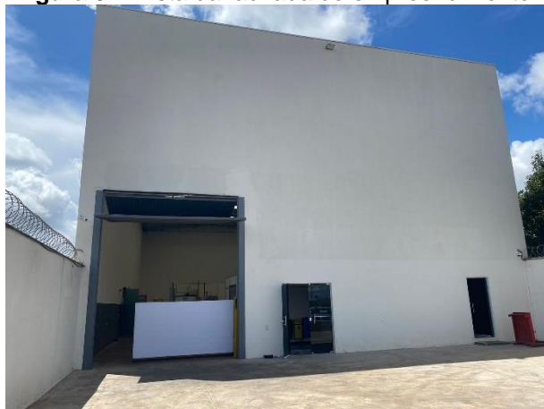
Figura 02: Vista da fachada do empreendimento.
