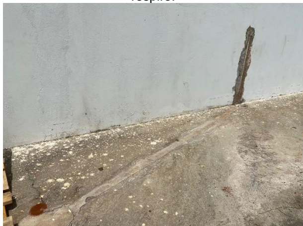
Figura 14: Local da fossa séptica concretado com respiro.
