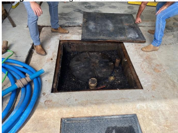
Figura 16: Biodigestor e caixa de inativação.
