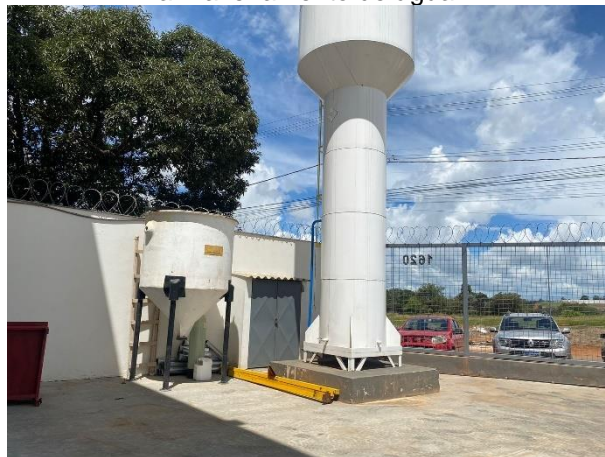
Figura 03: Tanque desativado e caixa de armazenamento de água.
