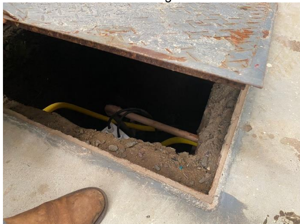
Figura 12: Poço tubular com bombeamento para caixa d'água.
